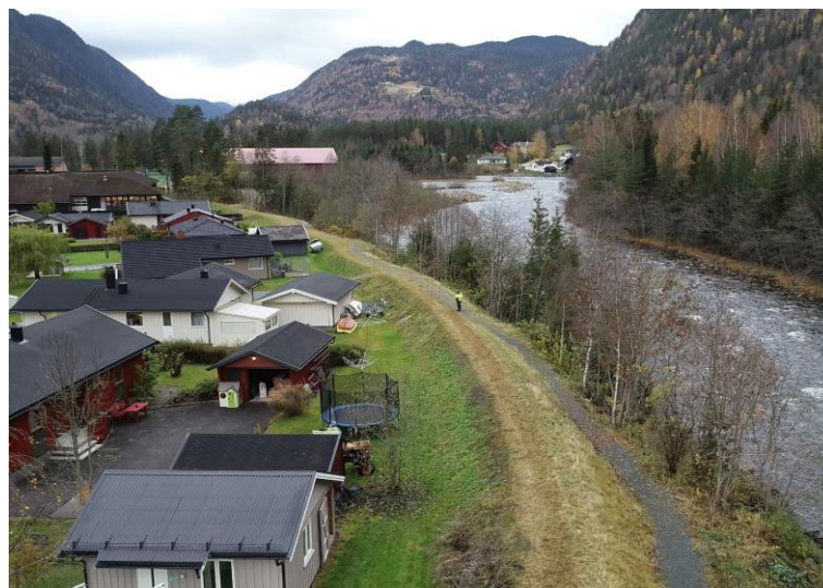
Figur 5-30: Flomvoll mot Tokkeåi, Dalen, Tokke kommune. Foto: Martin N. Jespersen, NVE, hentet fra Sikringshåndboka
