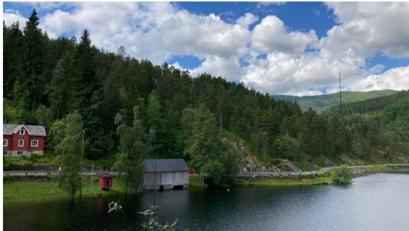
Figur 5-21. område ved innløp av flomtunnel ved Eikelandsfossen. Foto: Multiconsult 2022
