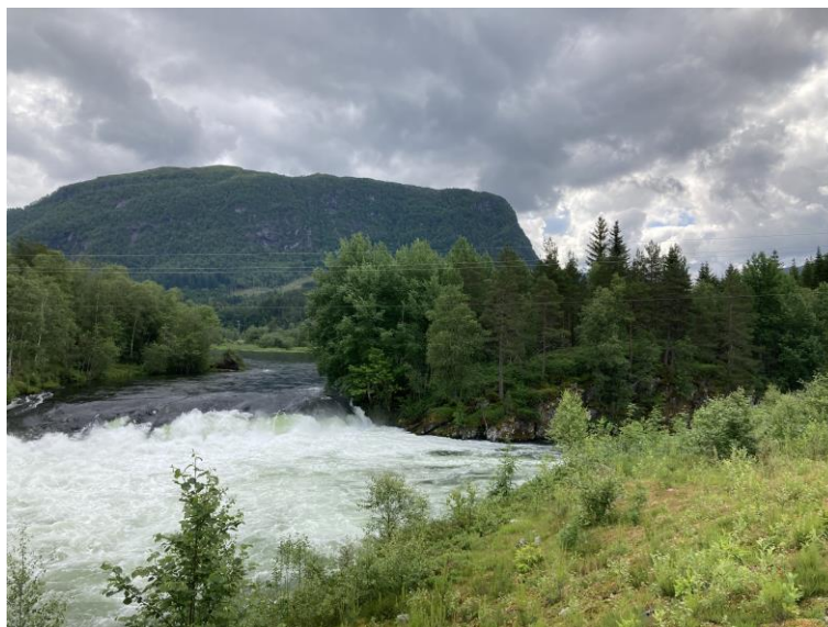
Figur 5-29. Sandafossen og inngrep området til høyre. Foto: Multiconsult 2022.
